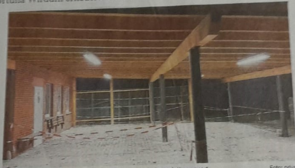
Die Überdachung am Sportheim in Wirdum wurde komplett erneuert.
